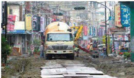
圖(三)污水下水道施工過程。(資料來源：中興工程顧問公司)
